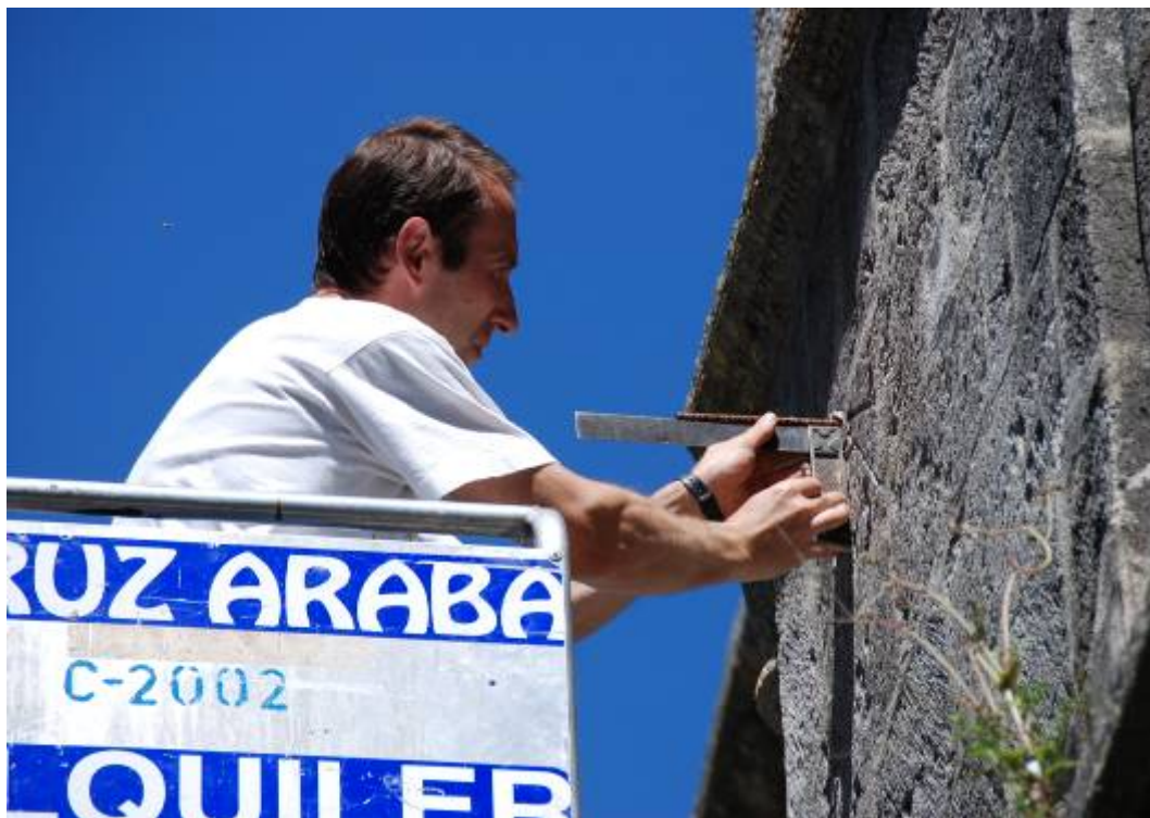
Reposición de la varilla (22 cm) del reloj canónico. ¡Con escuadra!
