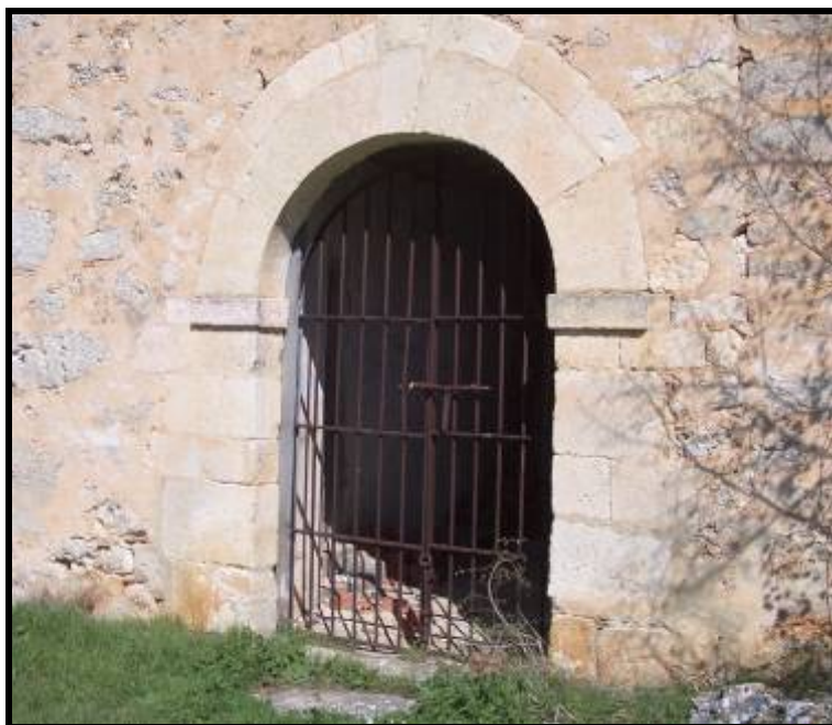
Sáseta. Arco de acceso al pórtico
