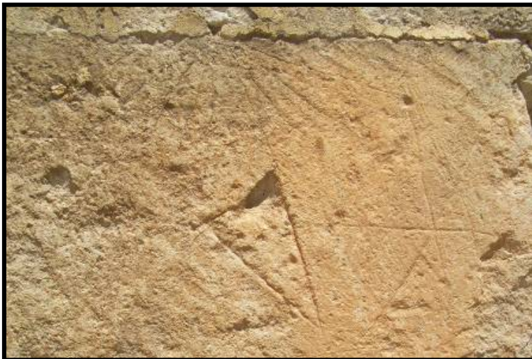
Reloj 1. Radial en junta de sillar.
