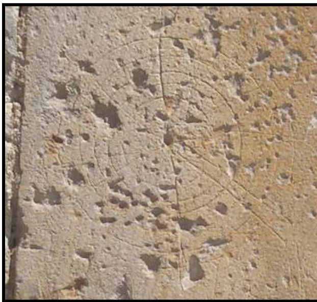
Circular en el centro del sillar.
