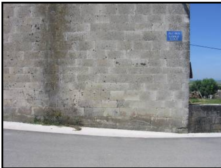
Muro este de la capilla de San Pedro de los Vicuñas.
