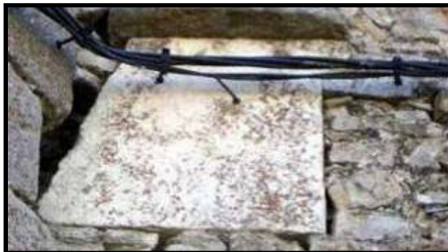
Reloj 1. Antes de las obras de 2006.
