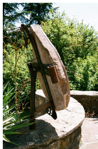
Foto de detalle del anclaje.
