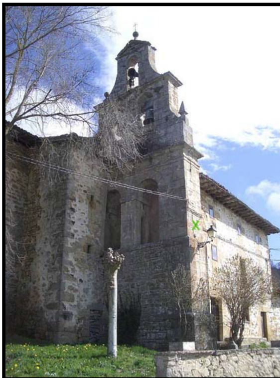
Jugo. Situación del reloj en el costado sur de la espadaña
