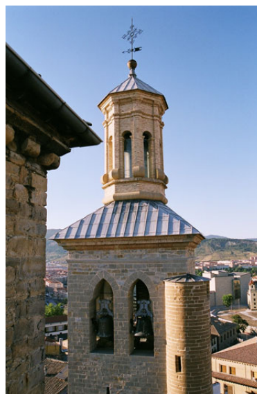
Torre norte de la iglesia de San Saturnino. Detalle de la escalera cilíndrica.
