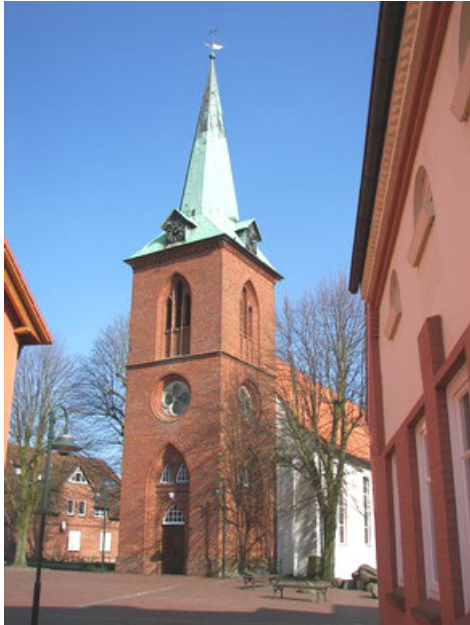
2: Torre de la iglesia de San Martín. Lado Poniente
