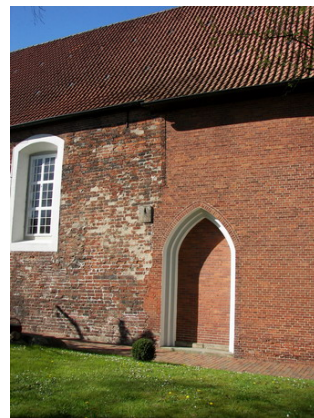
16: San Laurentius de Dedesdorf, parte de la pared Sur
