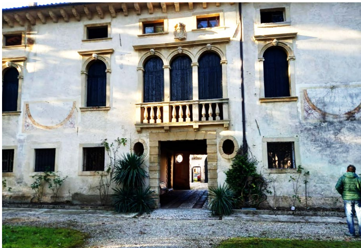
Fig. 1 – Facciata Sud-Est di villa Gera – Bellati a Campea di Miane (TV)
