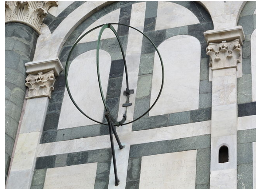
Armillilla Equinoccial de la fachada Sur de la basílica Santa María Novella de Florencia (Italia), para determinar el instante preciso del Mediodía Solar. Ignazio Danti 1572. Crédito de la fotografía: Francesco Bini. licensed under the Creative Commons Attribution-Share Alike 3.0 Unported
