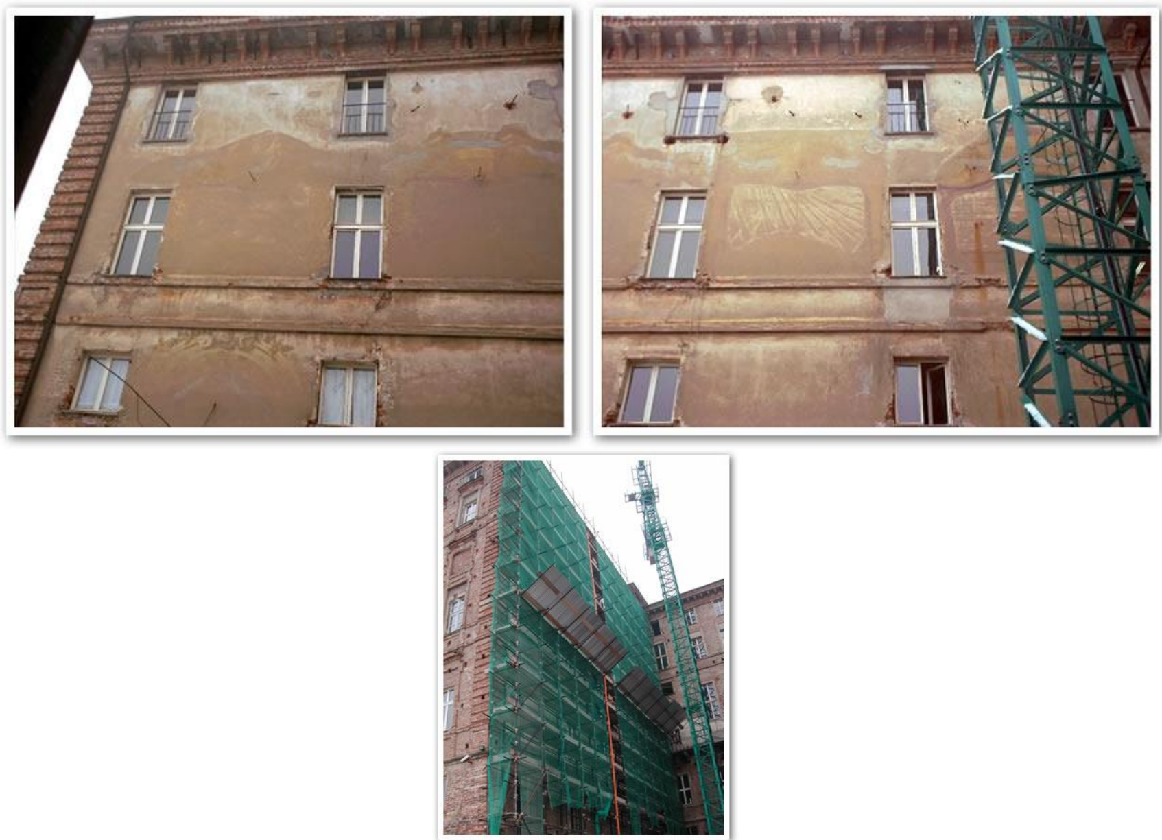
Figg. 01 – 02 – 03: Come si presentava la grande parete prima dei lavori.
