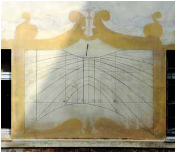
fig. 12 MONDOVÌ BREO (CN), Palazzo di Giustizia: orologio solare che indica l'azimut e l'altezza del sole. (foto R. Dionigi)
