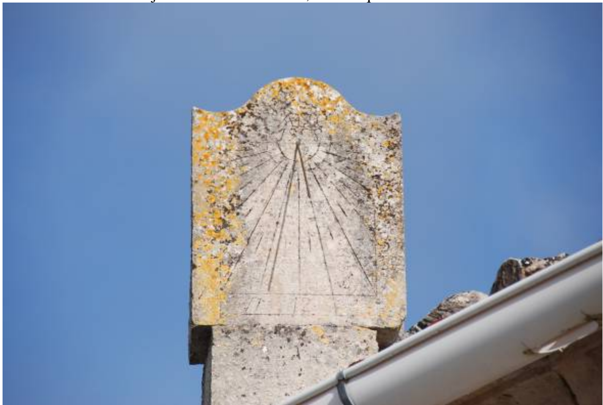
Situación del reloj de sol sobre la cornisa, en la esquina noroeste de la ermita.
