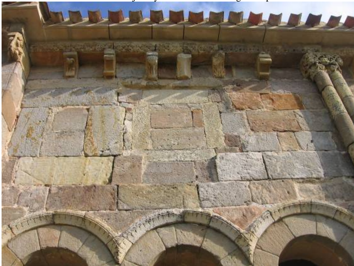
Ventanas abiertas en el muro de la galería porticada. Reloj de sol.
